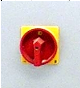
Obr. 2: Neoznačený hlavní vypínač
