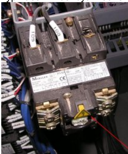
Obr. 3: umístění výstražné značky na hlavním vypínači
